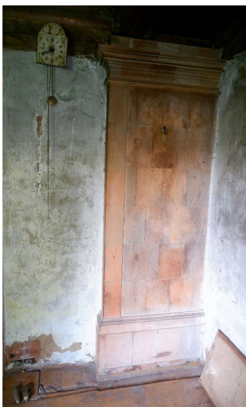
Iepriekšējās apkures ierīces (krāsns) pamatu vietas paliekas saimnieku istabā (V telpa). M. Varbūta foto.
