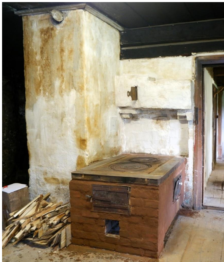
Lielvēveru plīts atjaunošanas procesa noslēgumā. Virs tās dūmu kanāls – ievads skurstenī. M.
