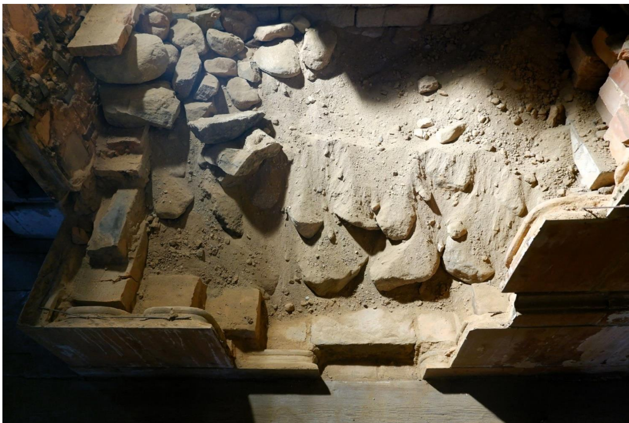
Akmeņu un smilšu masa zem kurtuves grīdas ķieģeļu slāņa. M. Varbūta foto.
