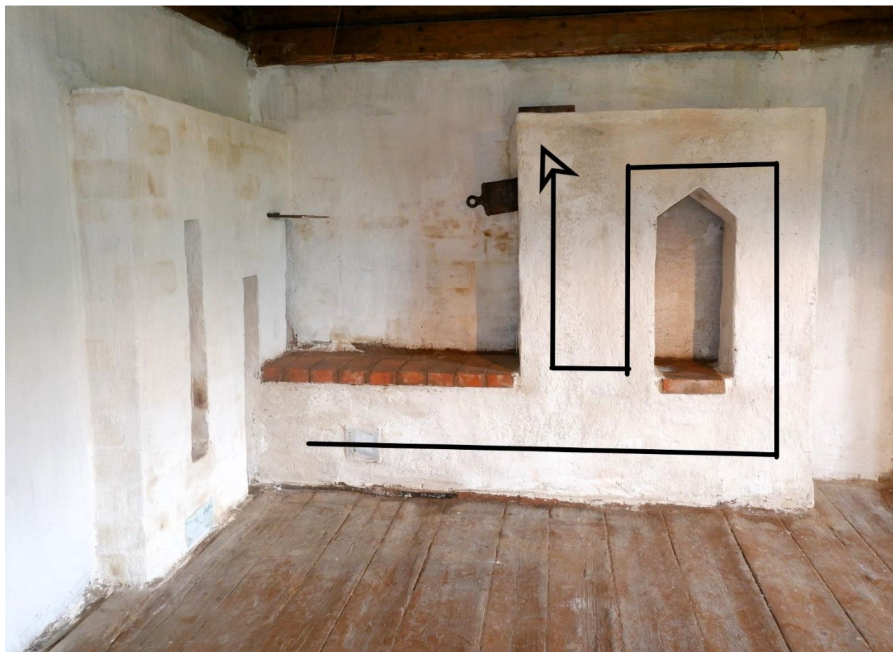
No jauna uzmūrētais sildmūris Lielvēveru saimes istabā ar dūmu kanālu shēmu. Foto M. Varbūts, shēmu sagatavoja E. Žīgurs
