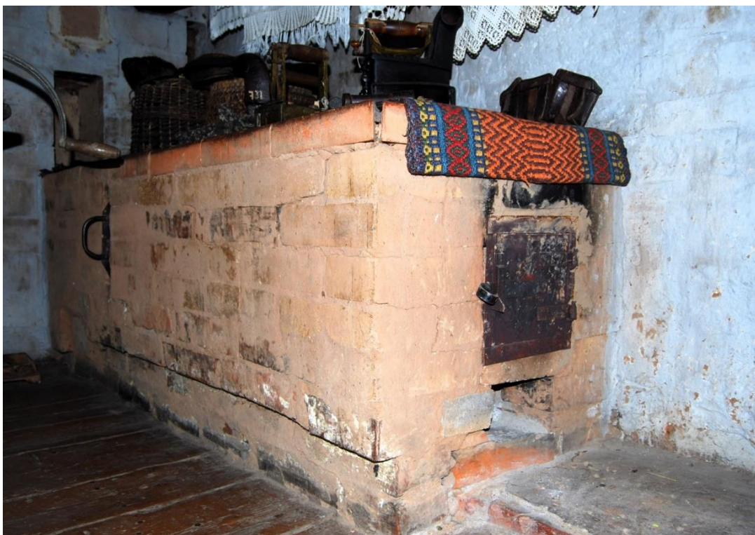
20. gs. otrā pusē uzmūrētais mūrītis Lielvēveru saimes istabā. Mūrīša priekšā redzami iepriekšējā sildmūra pamatne. M. Varbūta foto
