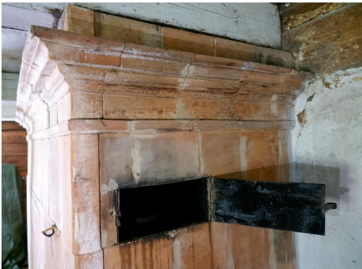
Krāsns priekšpusē iestrādātās metāla durtiņas paredzētas piekļuvei dūmu kanālam. M. Varbūta foto.
