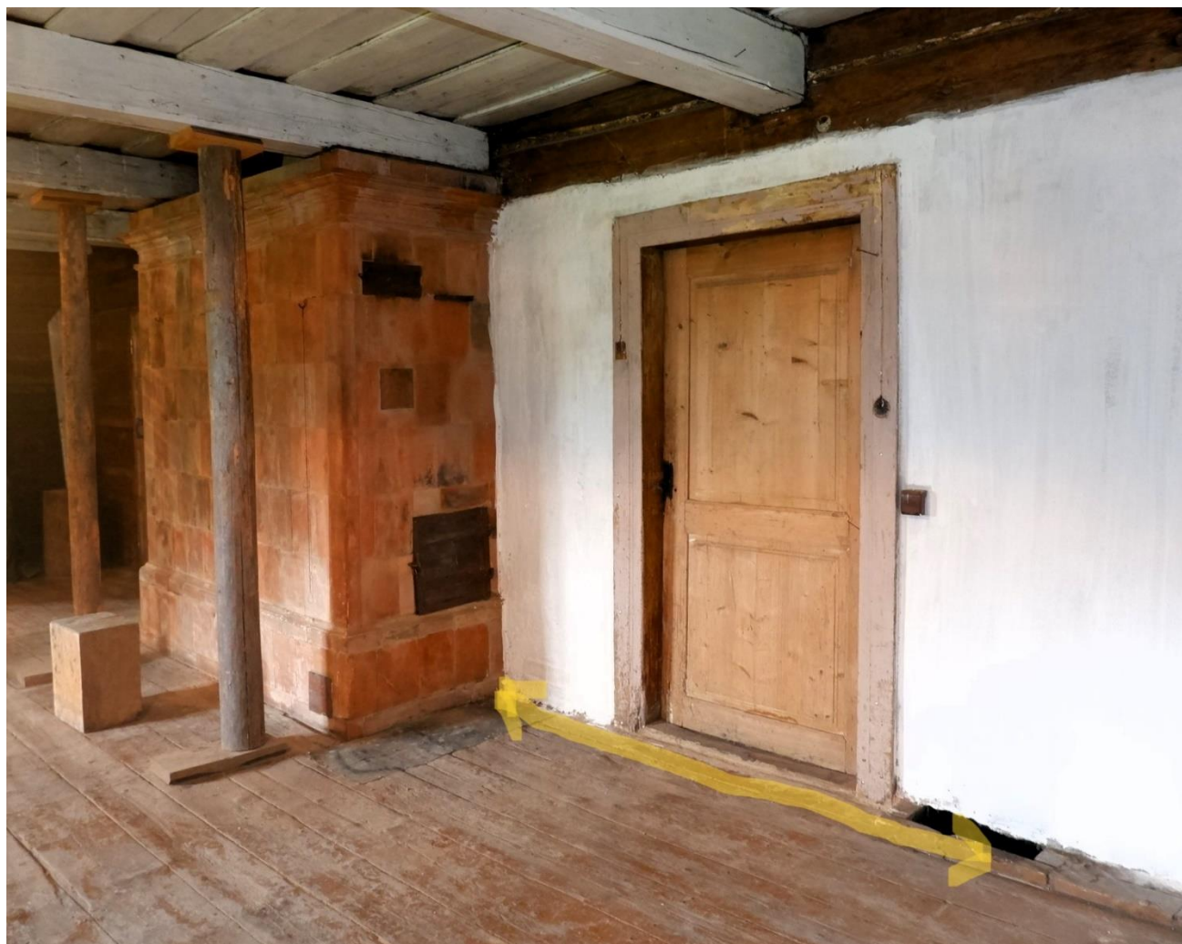
Saglabājusies zem grīdas izveidotā dūmu kanāla vieta uz senāko krāsni. M. Varbūta foto.
