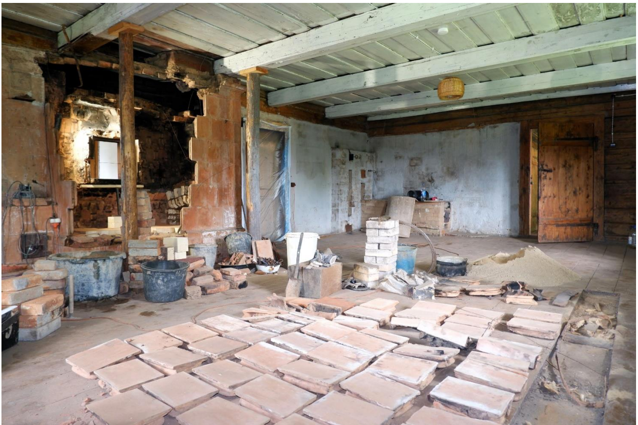
Restaurācijas procesā daļēji demontēta krāsns. Krāsns augšējā labā stūrī redzams dūmu kanāla izvads uz bēniņiem. M. Varbūta foto.
