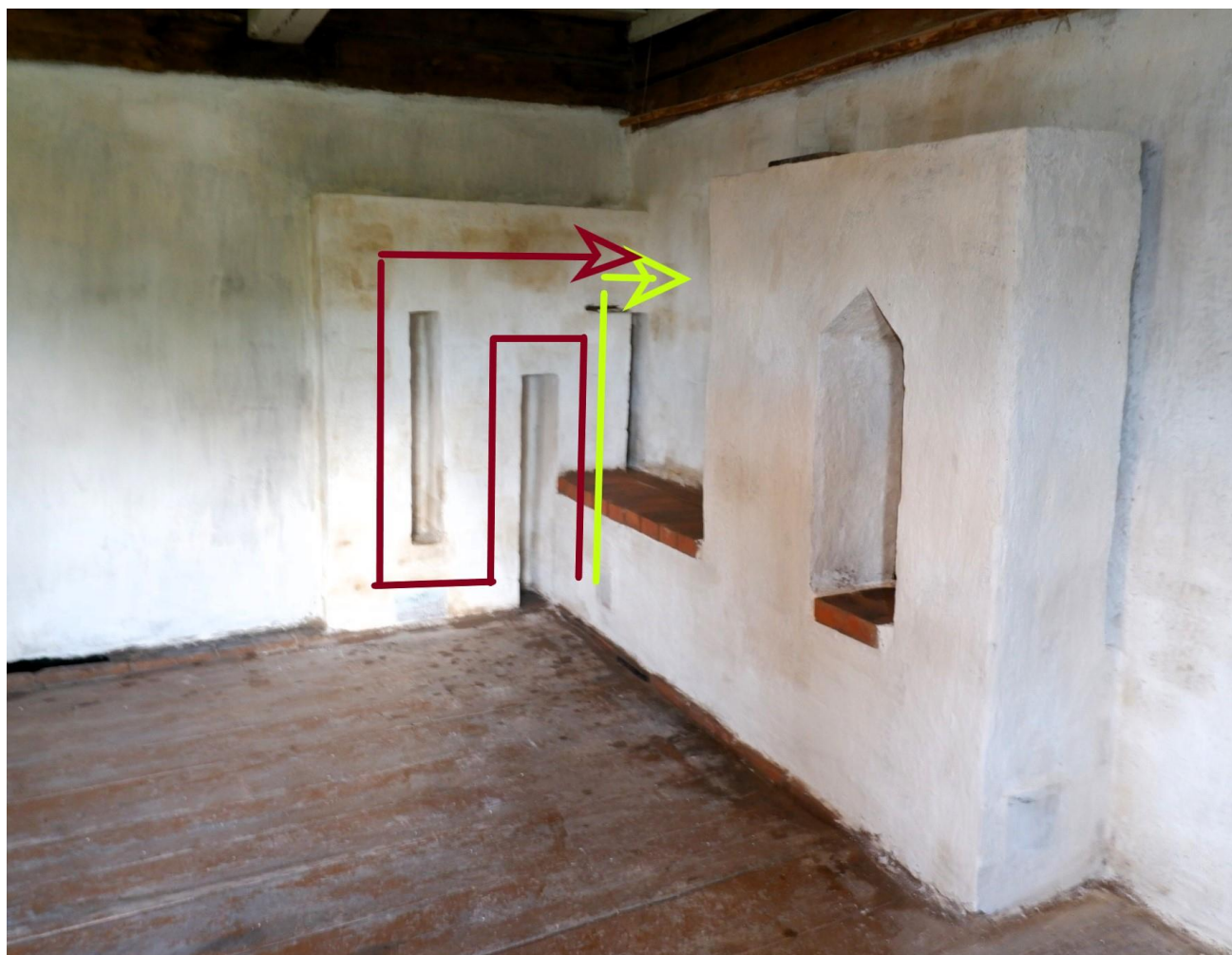
Augstāk minētā dūmu kanālu sistēma. Skats no Lielvēveru saimes istabas. Ar dzelteno līniju attēlots vasaras apkures variants, ar sarkano – ziemas. Foto M. Varbūts, shēmu sagatavoja E. Žīgurs
