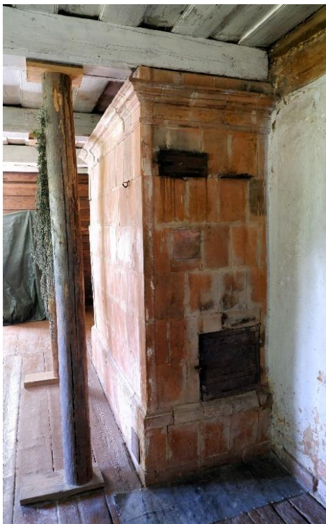
Krāsns priekšpuse ar augšpusē iestrādātiem aizvariem (šīberiem). M. Varbūta foto.
