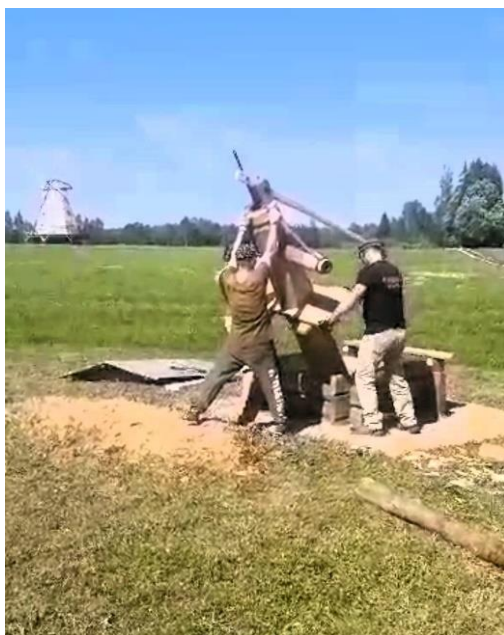
Sūkņa uzstādīšana (M. Kuplā foto)
