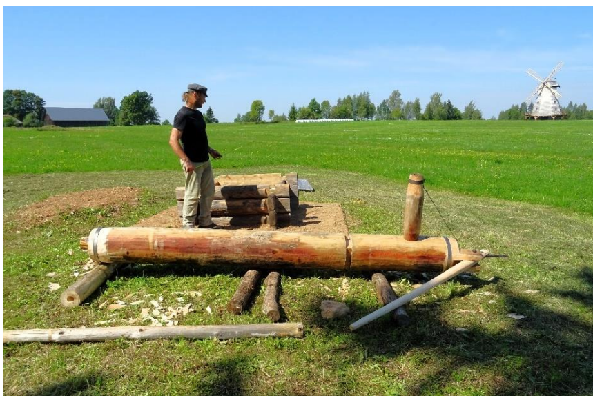
Sūknis sagatavots uzstādīšanai (E. Žigura foto)
