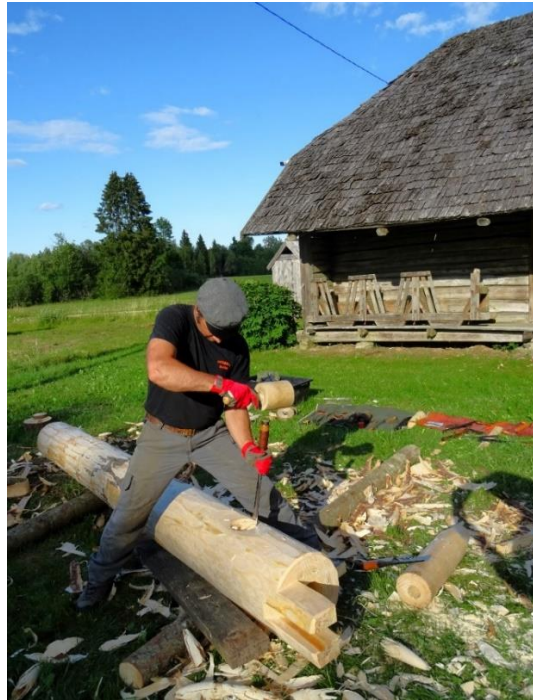
Ūdens iztekas caurules iestiprināšanas vietas sagatavošana ( E. Žīgura foto)
