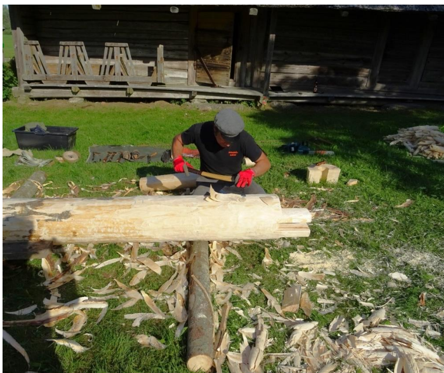
Ūdens iztekas caurules iestiprināšanas vietas sagatavošana (E. Žigura foto)
