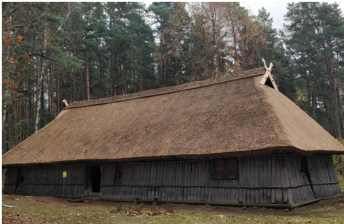
Attēls 3: Nidas dūmistaba pēc jumta rekonstrukcijas
