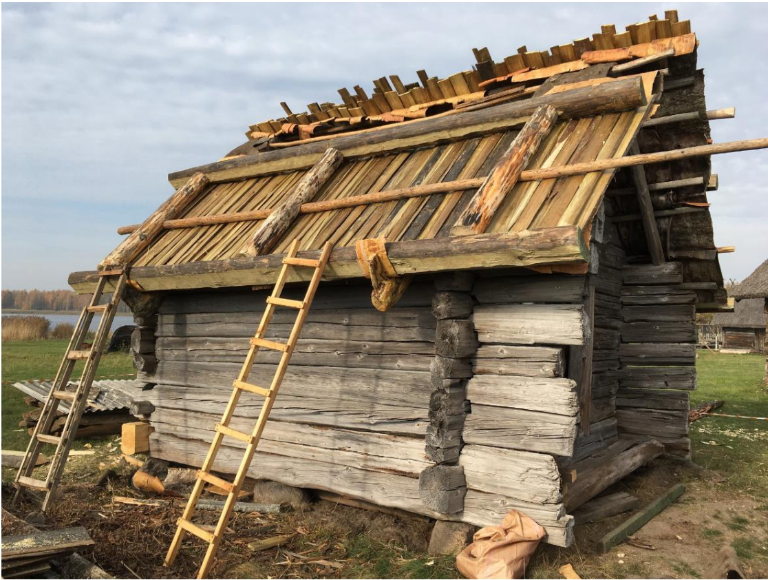
Attēls 3: “Žulnieku” tīklu būdas restaurācijas darbi Kurzemes zvejnieku ciemā
